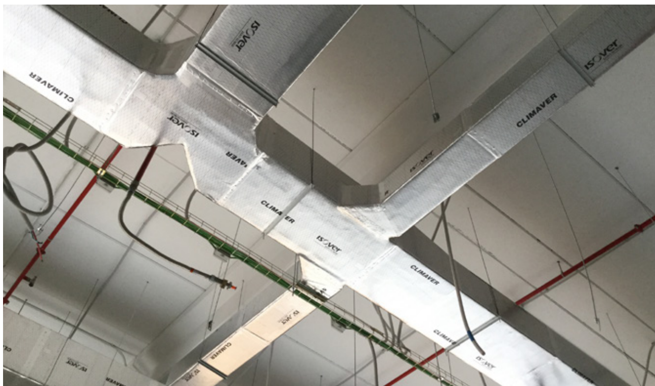
Instalacija kanala CLIMAVER® SDM oblik cipele
