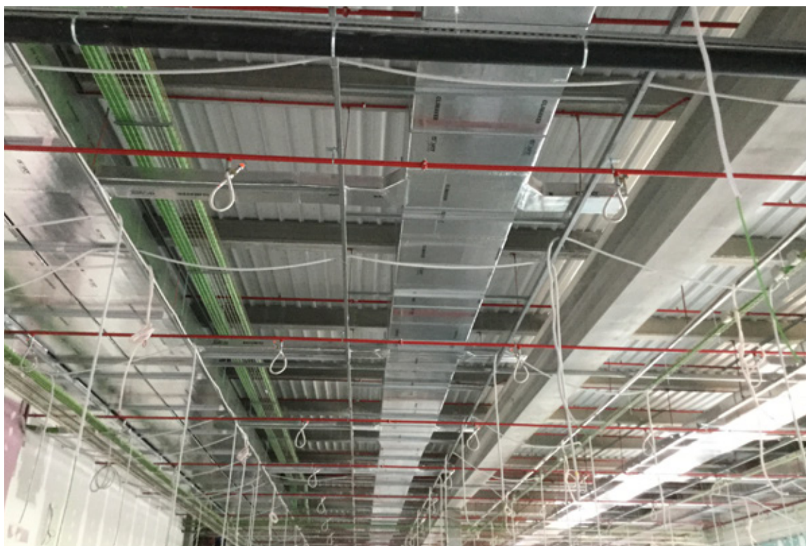
Montaža CLIMAVER® kanala
