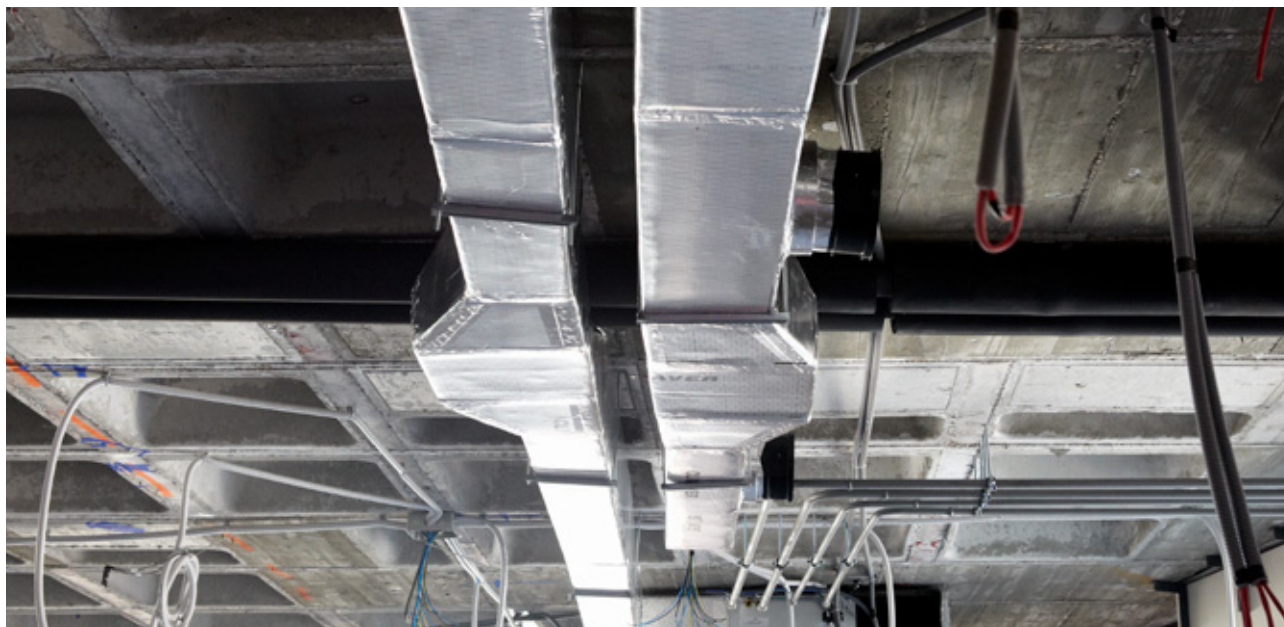
Montaža CLIMAVER® kanala
