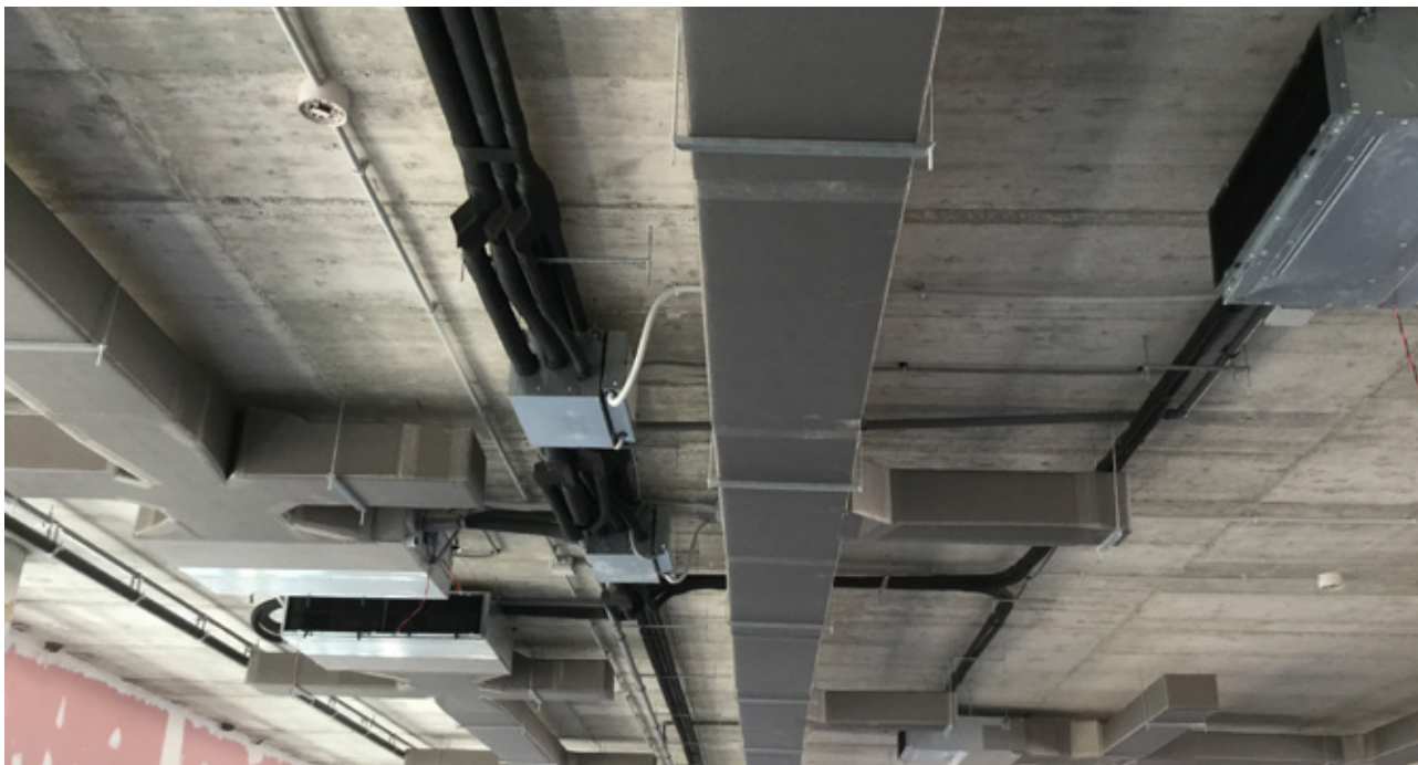
Instalacija kanala CLIMAVER® A2 DECO
