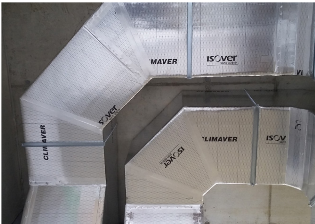
Montaža CLIMAVER® kanala
