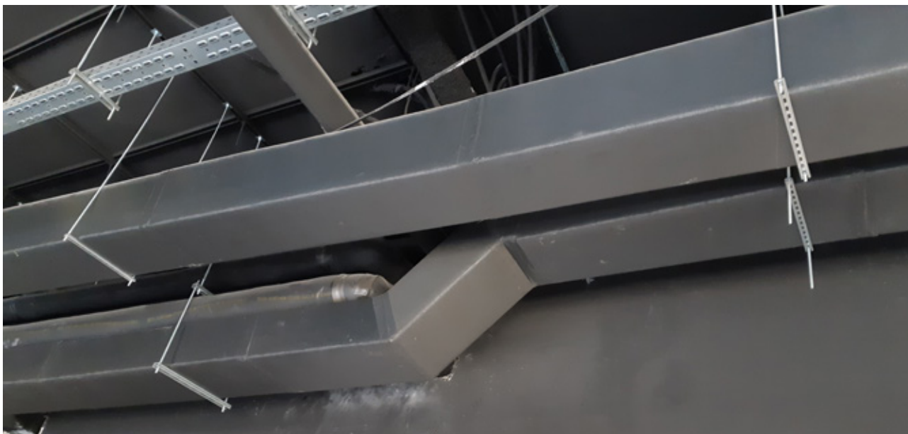
Instalacija kanala CLIMAVER® a2 DECO SDM ugao pomaka
