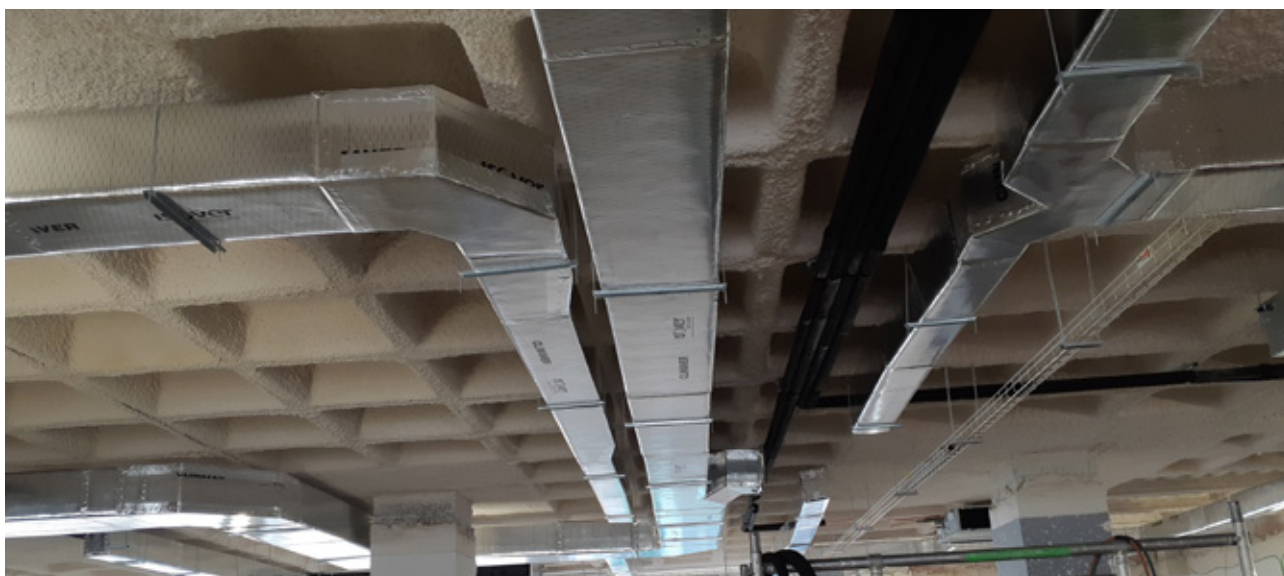
Instalacija kanala CLIMAVER® SDM redukcija
