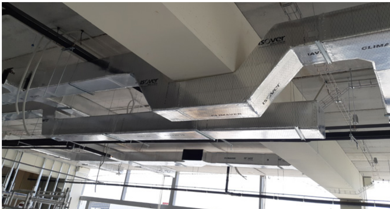
Instalacija CLIMAVER® kanala SDM prolaz grede
