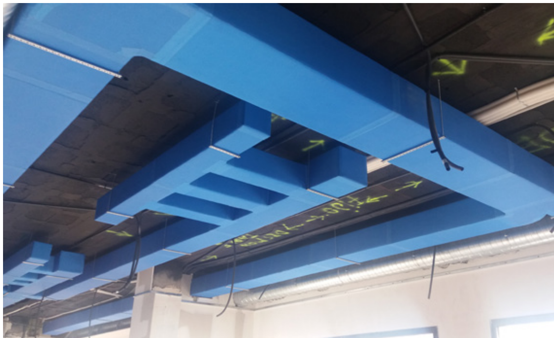
Nosač CLIMAVER® A2 DECO instalacije za ventilaciju
