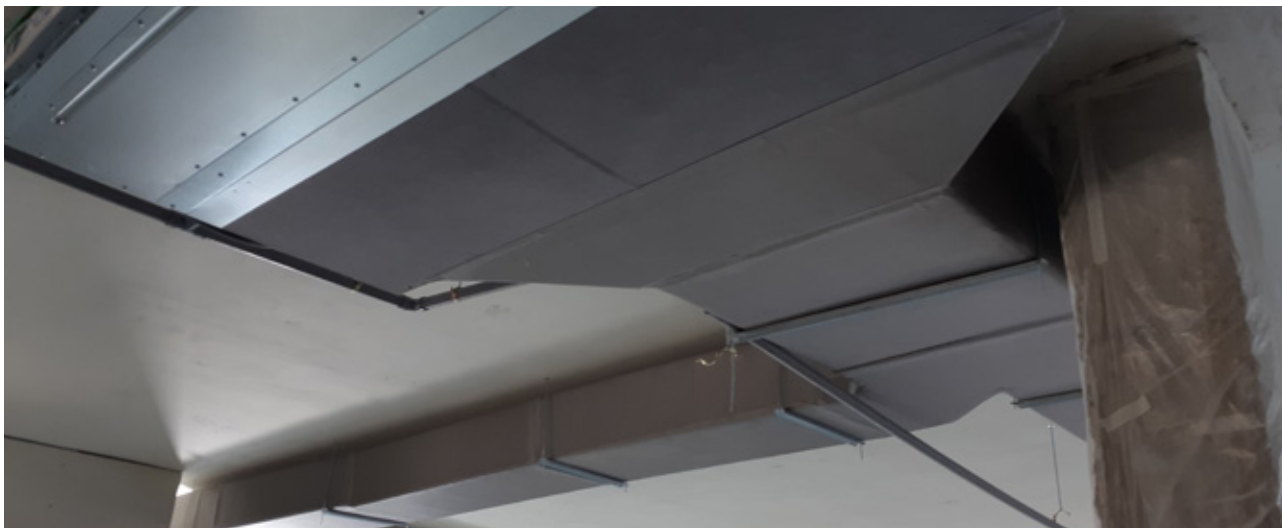
CLIMAVER® A2 DECO otvor za mašinu u instalaciji kanala
