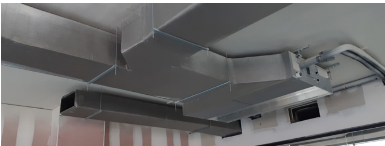
CLIMAVER® instalacija kanala SDM dvostrana redukcija za mašinu
